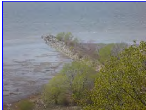
PHOTO 25: QUAÏ DE STE-FAMILLE EN ÉTAT AVANCÉ DE DÉGRADATION.
