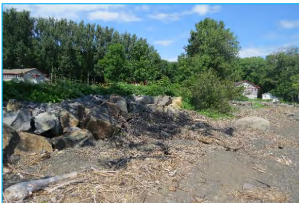
PHOTO 52 (À GAUCHE): RÉGÉNÉRATION DU SITE APRÈS LES TRAVAUX CORRECTIFS DE JUILLET 2023
